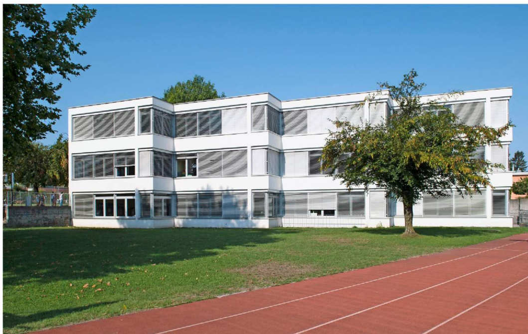
Im Sommer soll mit der Aufstockung des Schulhauses Feld 1 begonnen werden. Archivfoto: Michael Trost
